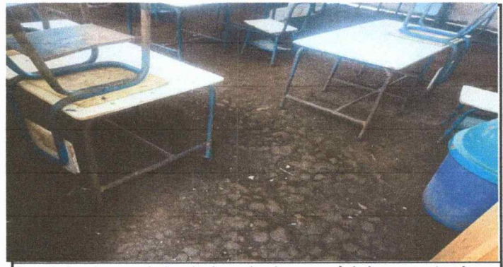
Foto 6: Se observa el piso de tierra donde se usará de los cemento y las arenas
